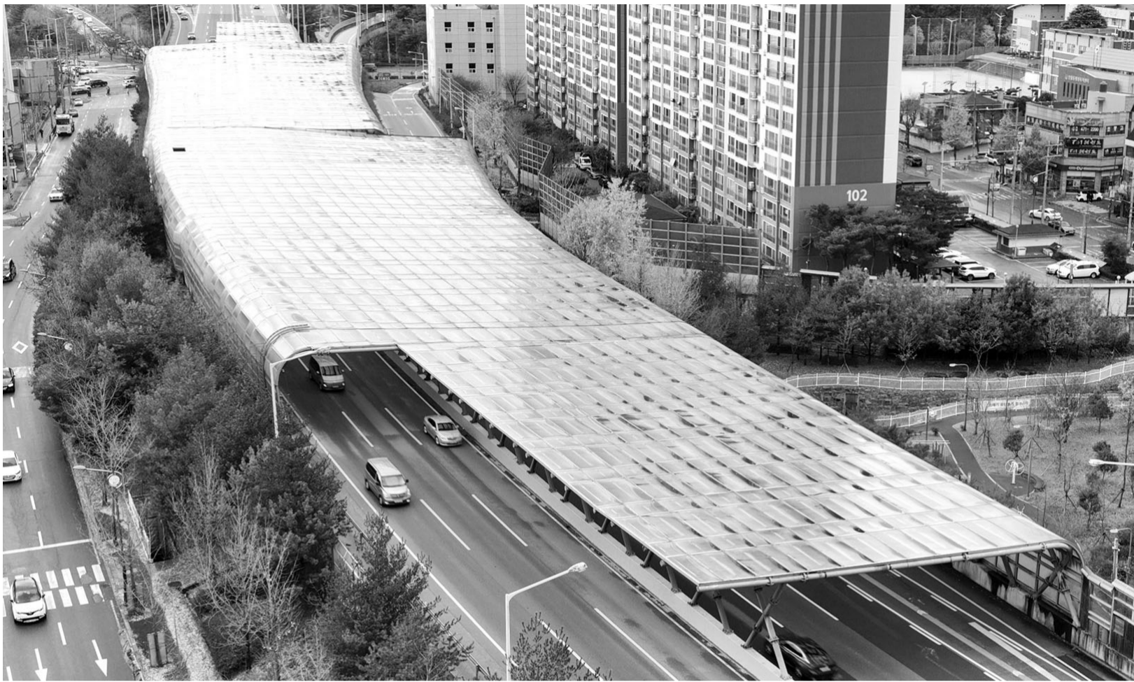
27일 광주시 남구 진월동 2순환도로 효덕교차로 일대에 있는 진월방음터널 전경. 2012년 준공된 이 터널은 천장과 벽면을 화재에 취약한 PMAA 플라스틱 소재로 만들었다.
