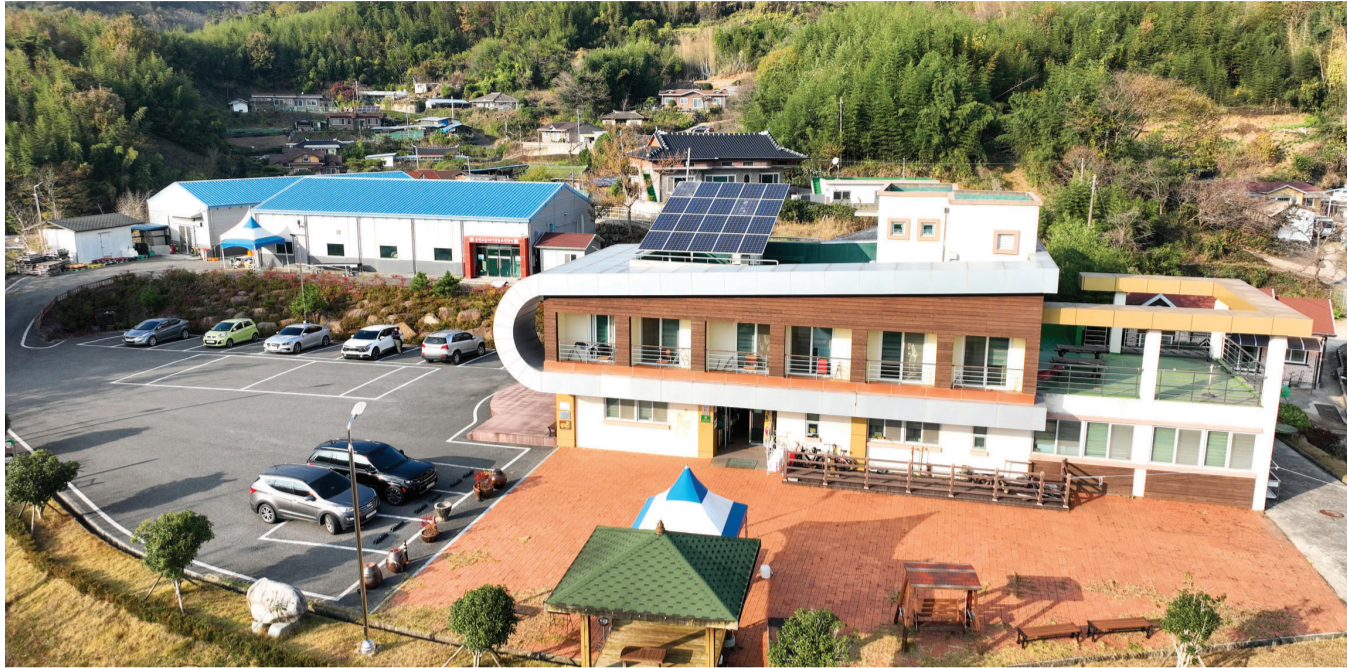
순천시 별량면 대룡리에 집적되어 있는 순천 고들빼기영농조합법인의 공장, 사무실, 전시관 등의 모습. 2005년 고들빼기 연구 및 상품 개발에 나선 유성진 대표가 김치부터 화장품까지 다양한 상품을 개발·연구하는 거점이다.
