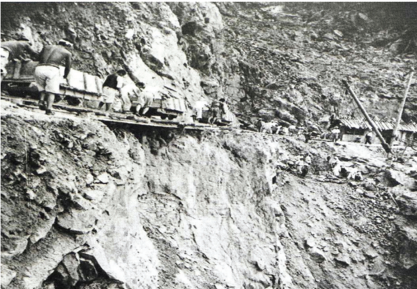
일제 강점기 노천광산에서 강제노역 하는 조선인들 모습. 당시 조선인들은 절벽에 아슬아슬하게 깔려있는 레일을 통해 직접 수동으로 밀면서 운반하는 일명 ‘수압계도’를 이용해 광물을 운반했다. <해남 옥매광산 노무자들의강제동원 피해실태 조사서 수록 사진>
