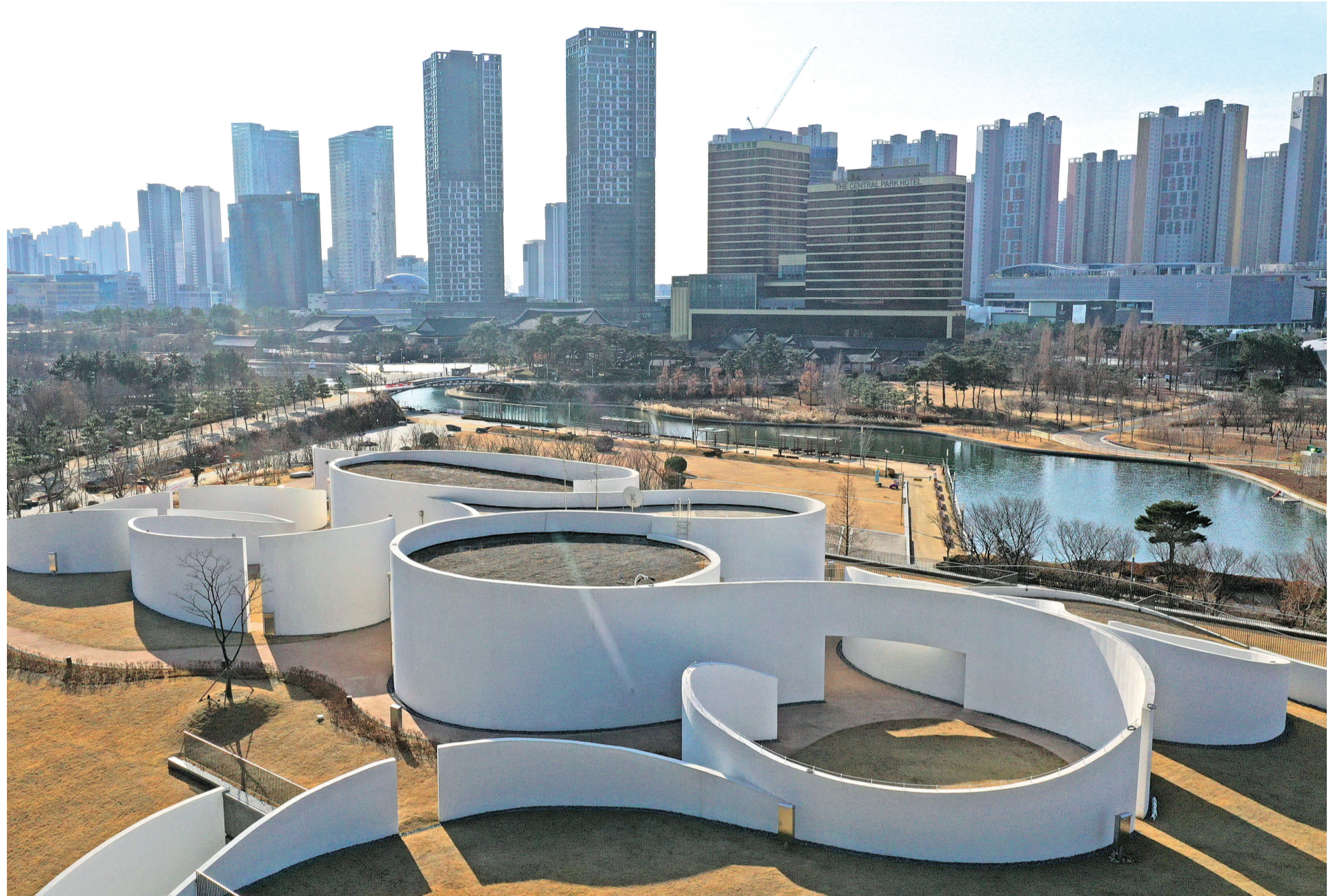
송도센트럴파크 부지에 세워진 국립세계문자박물관은 공원의 풍경과 이질감이 없도록 건물 지붕을 잔디로 덮었다. 공원의 조형물처럼 박물관으로 향하는 산책로를 조성해 이곳을 찾는 이들이 자연스럽게 문자의 세계를 접할 수 있도록 설계를 기획했다.
