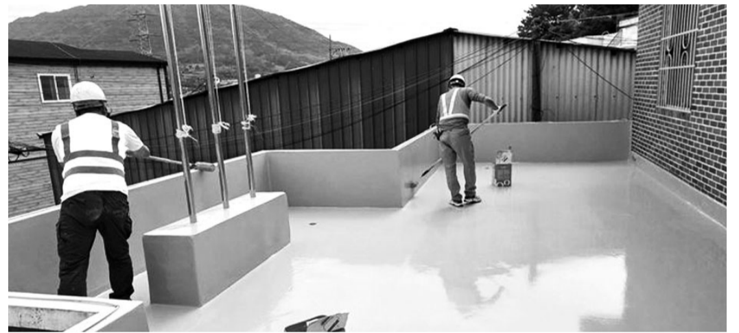
마을회관 옥상에 차광 페인트를 도색하는 시원지붕 시공 작업을 하고 있는 모습.
