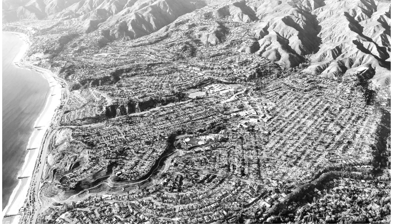
13일(현지시간) 캘리포니아주 퍼시픽 펠리세이즈에서 산불로 인해 파괴된 LA 지역 주택들. 로스앤젤레스 카운티 전역에서 타오른 불로 대피령 또는 경고를 받은 사람은 17만명이 넘고 24명이 숨졌다. 또 1만2000개 이상의 구조물이 파괴되거나 손상됐으며, 1만41630ha 이상이 불에 탔다. /연합뉴스
