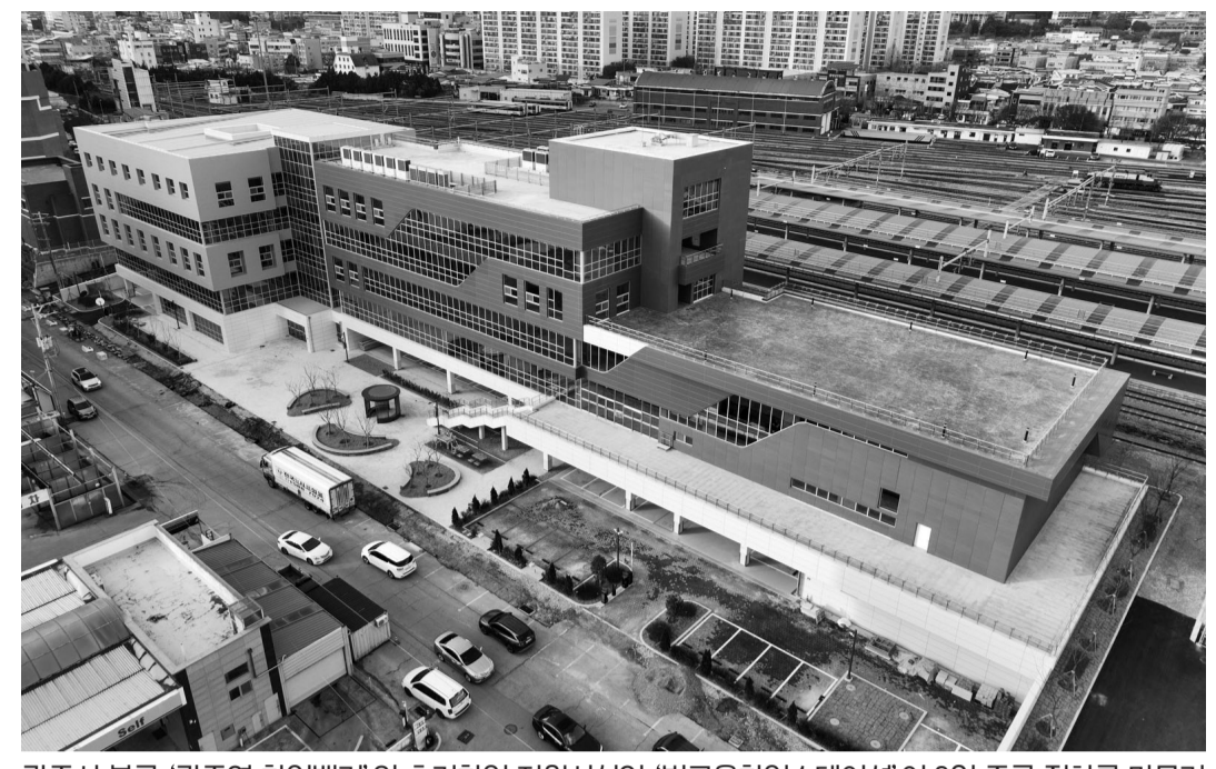
광주시 북구 '광주역 창업밸리'의 초기창업 지원시설인 '빛고을창업스테이션'이 3일 준공 절차를 마무리하고, 외관을 드러냈다. 총 공사비 350억원이 투입돼 지상 5층(연면적 8950㎡) 규모로 조성됐으며, 42개 기업·기관이 입주할 예정이다. /김진수 기자 jeans@kwangju.co.kr
