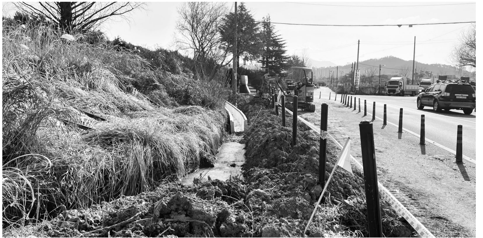
20일 광주시 광산구 신창동 유적지 내에 배수로가 파이고 콘크리트 배수관이 설치돼 있다.
