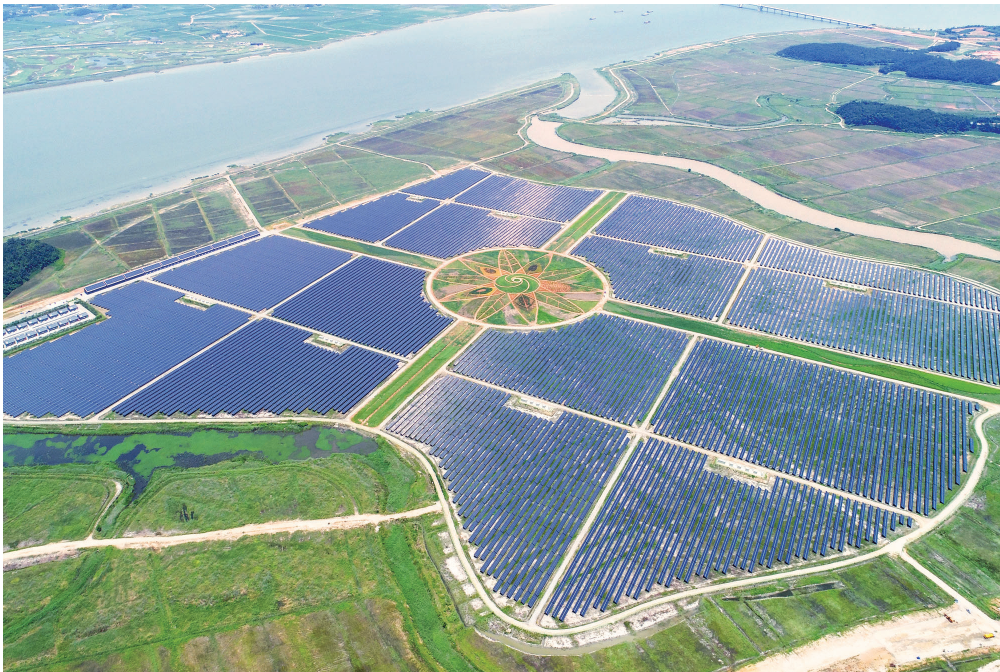
98MW 태양열 발전 설비와 다채로운 식물이 식재된 태양의 정원 전경.
