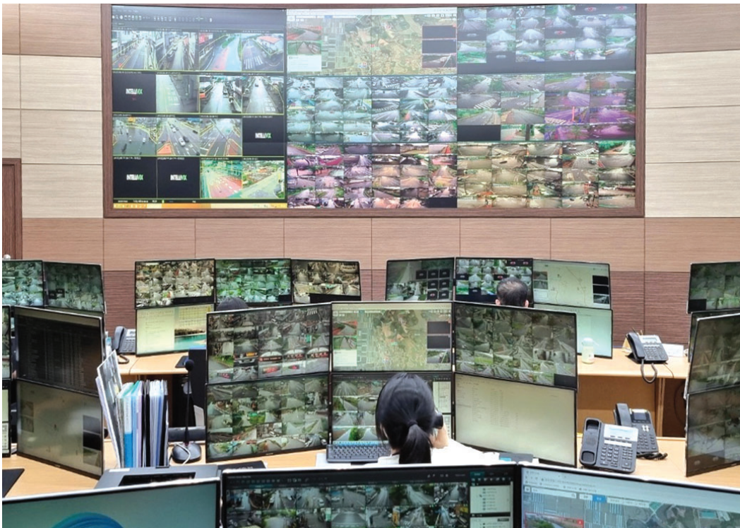
나주시 CCTV 통합관제센터.
