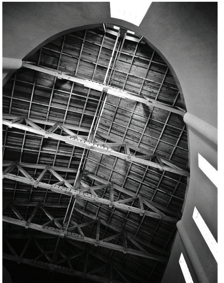
구정아트센터 내부 전경 모습.
