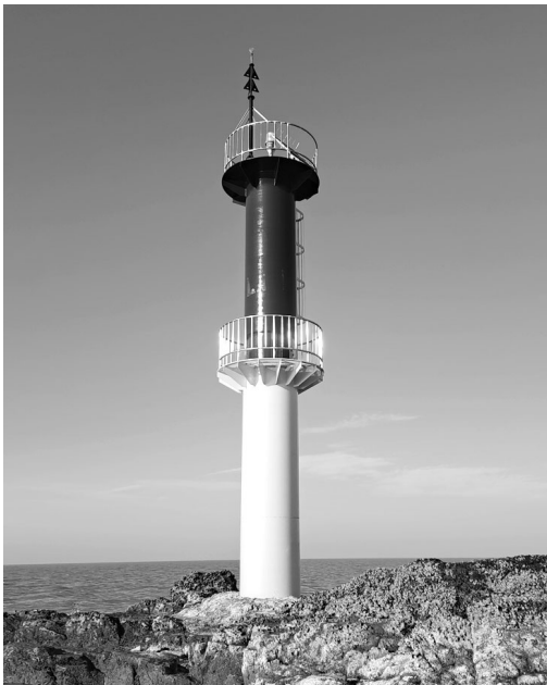
영광 송이도 해상 수중암초에 설치된 등표.
