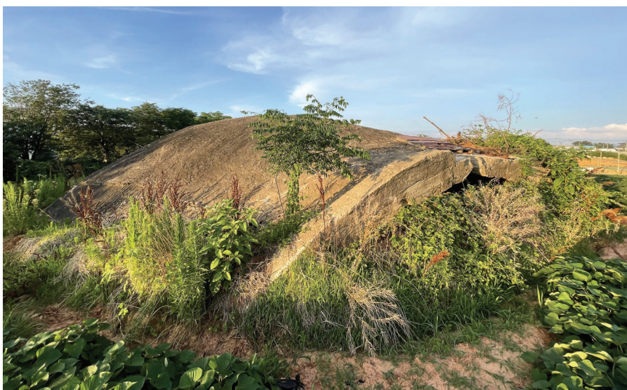
왼쪽부터 무안군 망운면 목동리의 한 고구마 밭 옆에 있는 격납고의 뒷면이 토사와 수풀로 막혀있다. 입구의 천장 테두리 부분은 훼손돼 철골이 드러나있는 모습이다. 무안군 현경면 평산리 유수정마을 인근에 있는 격납고의 입구는 바닐로 막혀있다.
