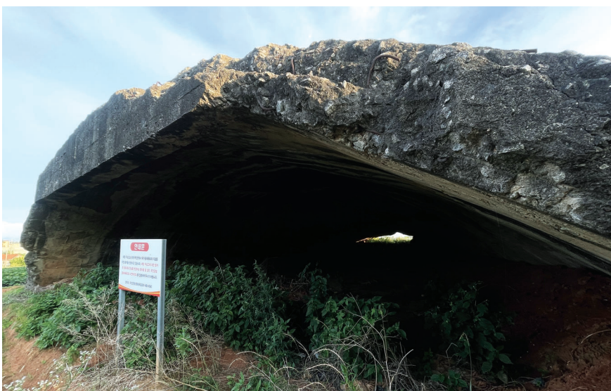
왼쪽부터 무안군 망운면 목동리의 한 고구마 밭 옆에 있는 격납고의 뒷면이 토사와 수풀로 막혀있다. 입구의 천장 테두리 부분은 훼손돼 철골이 드러나있는 모습이다. 무안군 현경면 평산리 유수정마을 인근에 있는 격납고의 입구는 바닐로 막혀있다.
