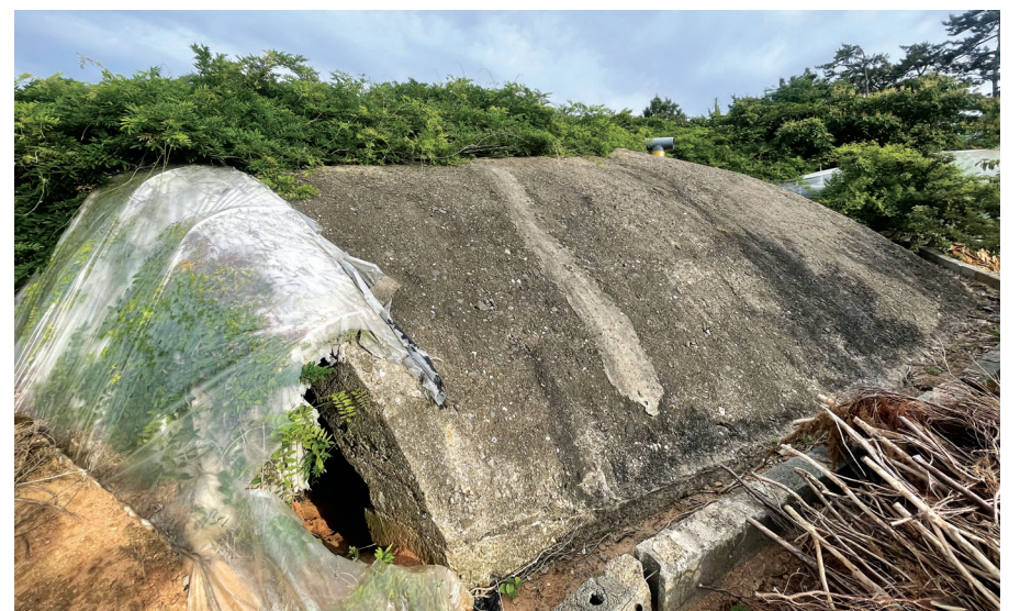
왼쪽부터 무안군 망운면 목동리의 한 고구마 밭 옆에 있는 격납고의 뒷면이 토사와 수풀로 막혀있다. 입구의 천장 테두리 부분은 훼손돼 철골이 드러나있는 모습이다. 무안군 현경면 평산리 유수정마을 인근에 있는 격납고의 입구는 바닐로 막혀있다.
