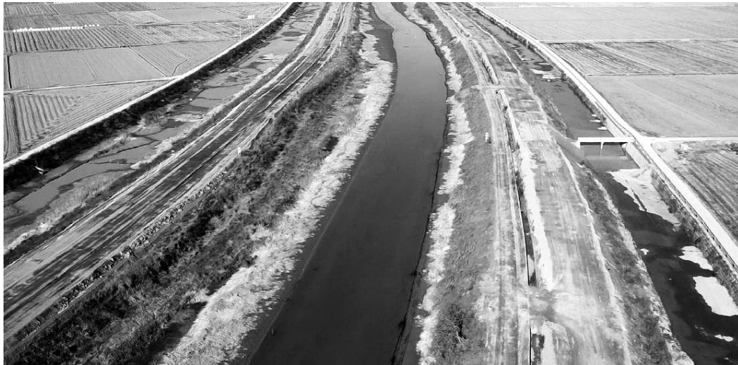
정읍 감곡면 감곡천 공사 구간.
