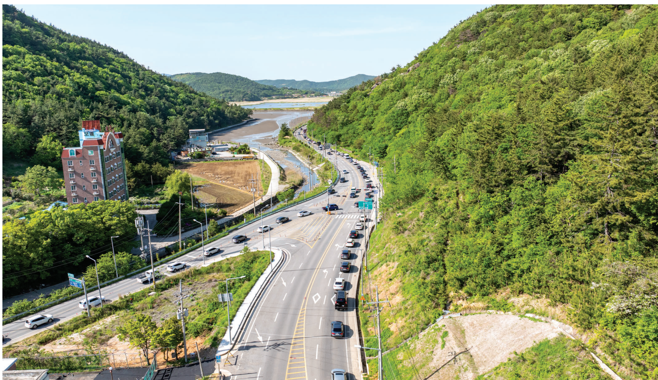
국도 17호선 돌산 우두~신북 구간은 여수 지역 관광객 증가로 교통 체증이 자주 발생하면서 차선 확장 필요성이 커진 상태다.
