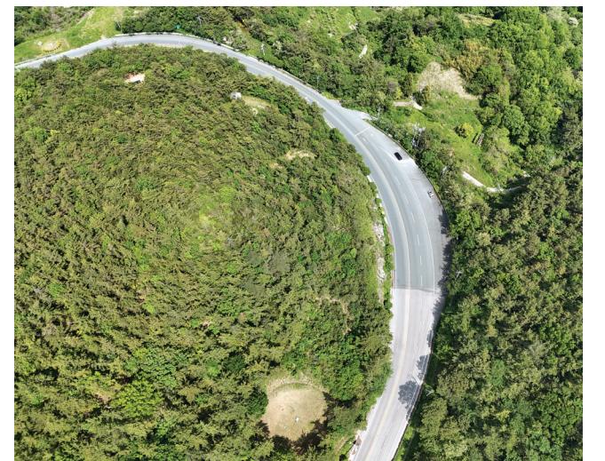
국도 23호선인 장흥군 대덕읍 신리~장흥읍 순지리 구간 전경.
