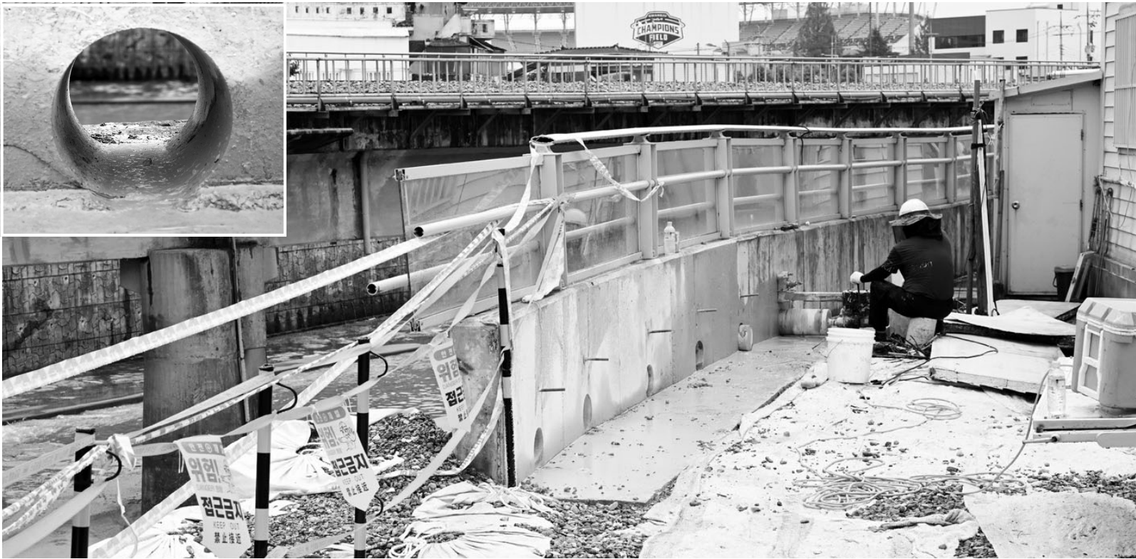
침수 예방 교육책...홍수방어벽에 배수 구멍 5일 광주시 북구 신안동 서방천 일대 홍수방어벽에 작업자들이 침수 예방을 위한 배수 구멍을 뚫고 있다. 왼쪽 위가 배수 구멍. /나명주기자mjna@kwangju.co.kr
