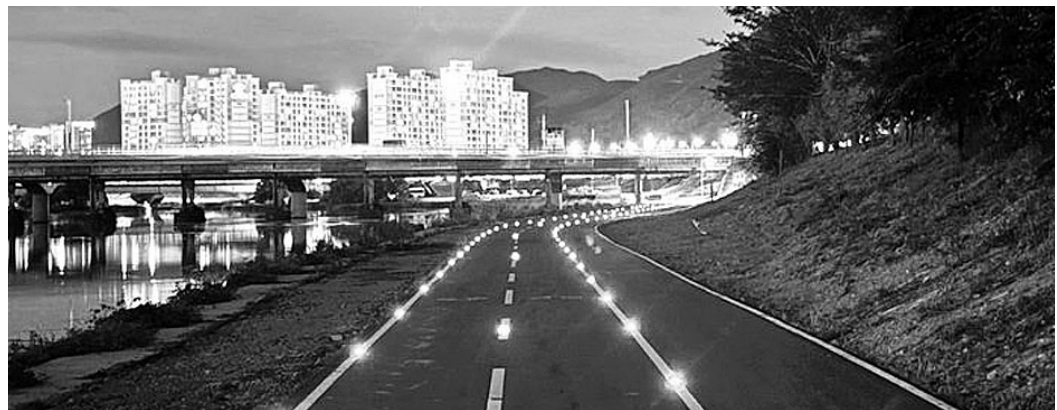
장성군 황룡강변 일대 자전거 도로에 설치된 활주로형 야간 조명.
