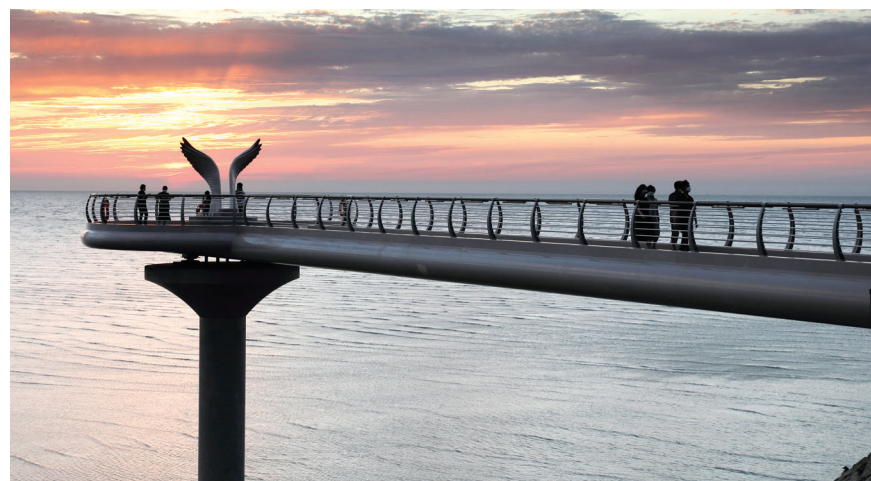
영광 백수해안도로 노을전망대 전경.
