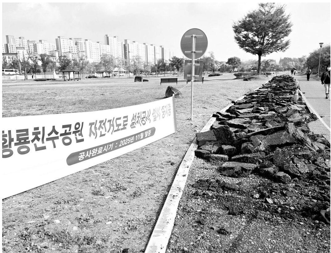
9일 광주시 광산구 황룡친수공원에 자전거 도로 공사 아스콘이 100여m 떨어진 상태로 10여일째 방치되고 있다.
