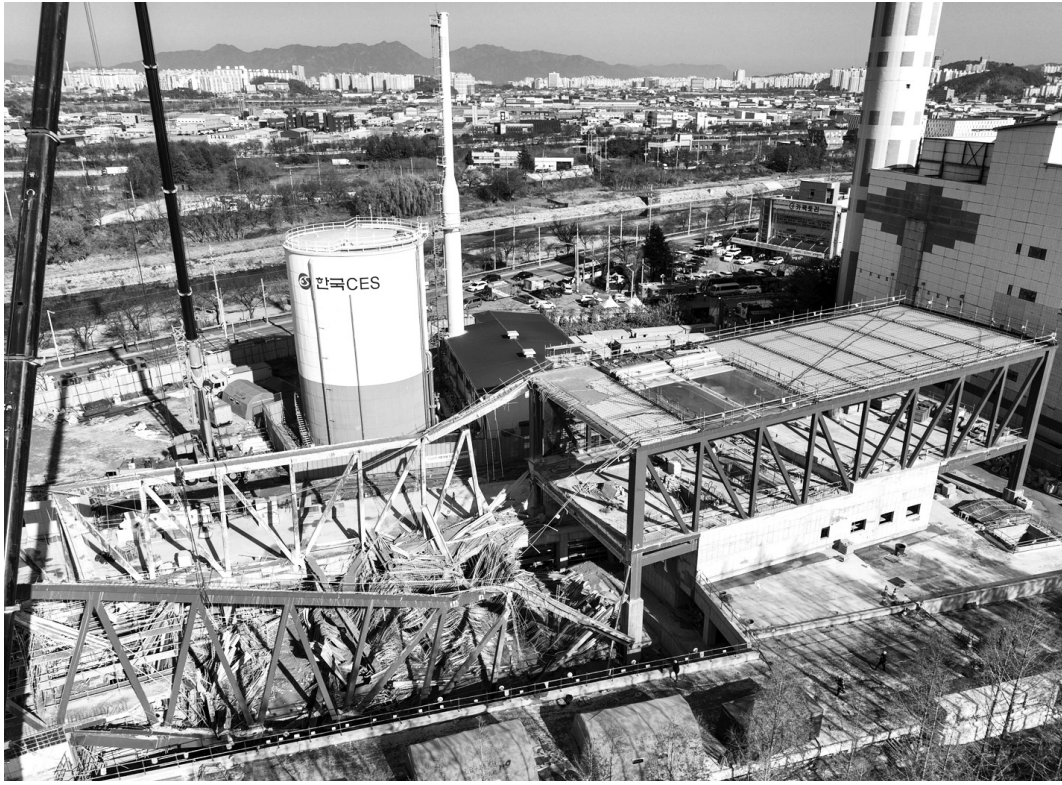
지난달 11일 붕괴 사고가 발생한 광주시 서구 내방로 광주대표도서관 건립 공사 현장. 상판의 콘크리트 데미가 바닥으로 내려앉았다. /김진수 기자 jeans@kwangju.co.kr
