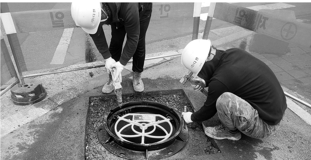
맨홀 추락방지 시설 설치 현장 모습.
